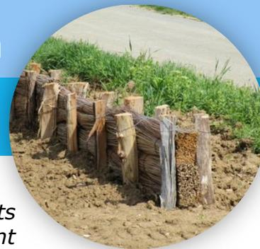
Une fascine est un dispositif « d'hydraulique douce » constituée de fagots de bois superposés, fixés au sol entre deux rangées de pieux, dont l'objectif est de faire obstacle aux coulées de boue.
